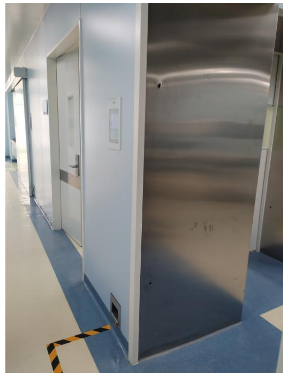
图 4-4 受检者门红外防夹和脚踩感应装置
