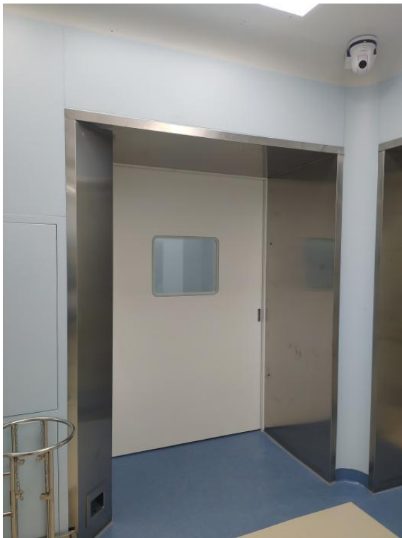
图 4-9 机房内摄像监控装置
