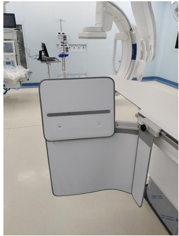
图 4-8 床侧铅防护屏和铅防护帘
