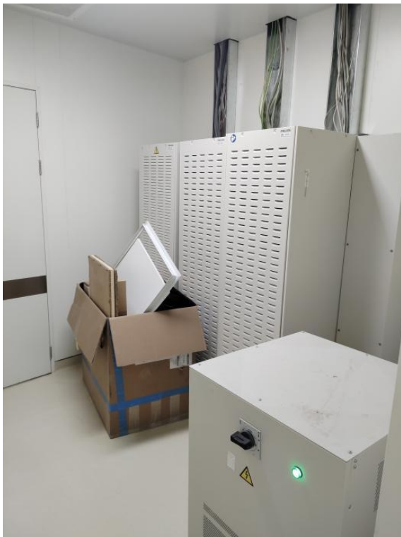
图 4-13 机房南侧设备间
