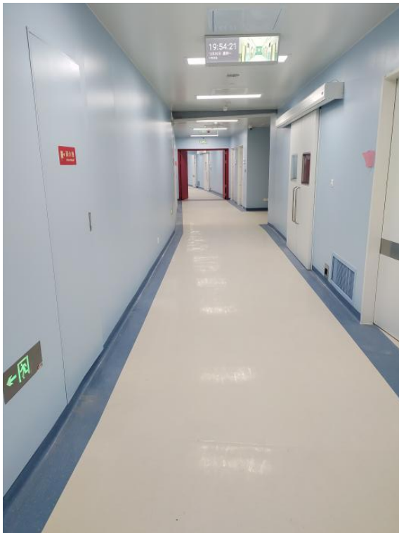
图 4-11 机房北侧走廊
