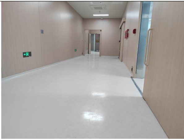
图 3-19 机房西侧走廊
