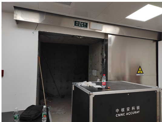
治疗室西侧预留加速器机房
