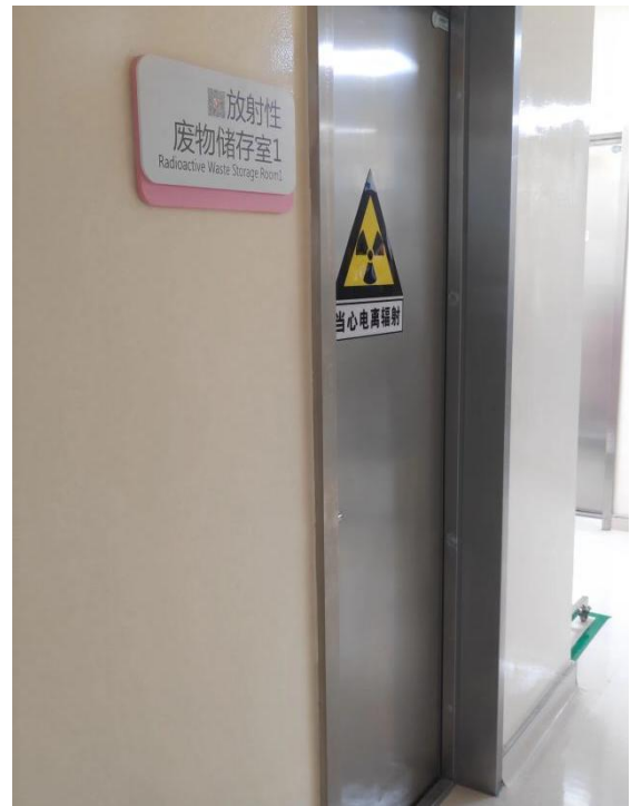
图 4-16 放射性废物储存室
