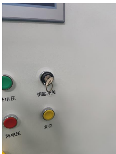
图 5-2-13 控制柜钥匙开关
