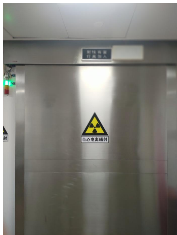
图 4-3 后装治疗室人员进出门
