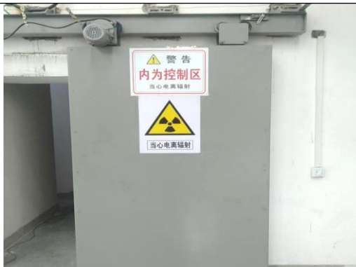
图 7-5 一层辐照室进出门
