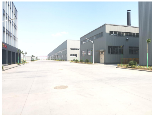
图 7-18 辐照室东侧和北侧
