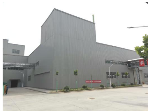
图 7-4 辐照室北侧外景
