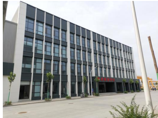
图 7-2 辐照室北侧研发中心
