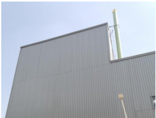
图 7-17 辐照室排风系统排风管
