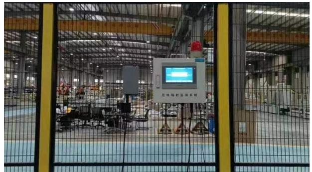
图 4-10 研发区固定式场所辐射探测报警装置
