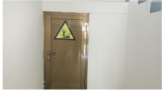
危废暂存间北门（常闭）
