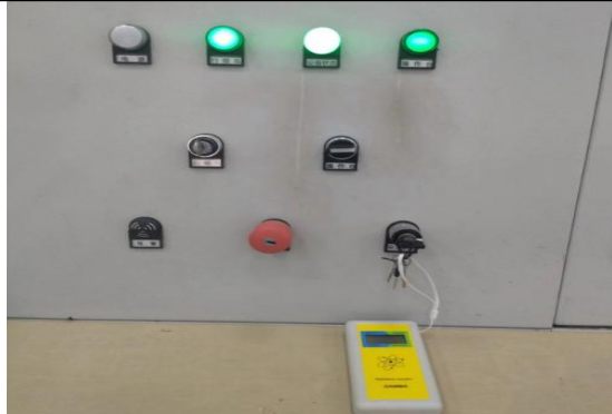
控制室控制台急停按钮及安全联锁钥匙开关
