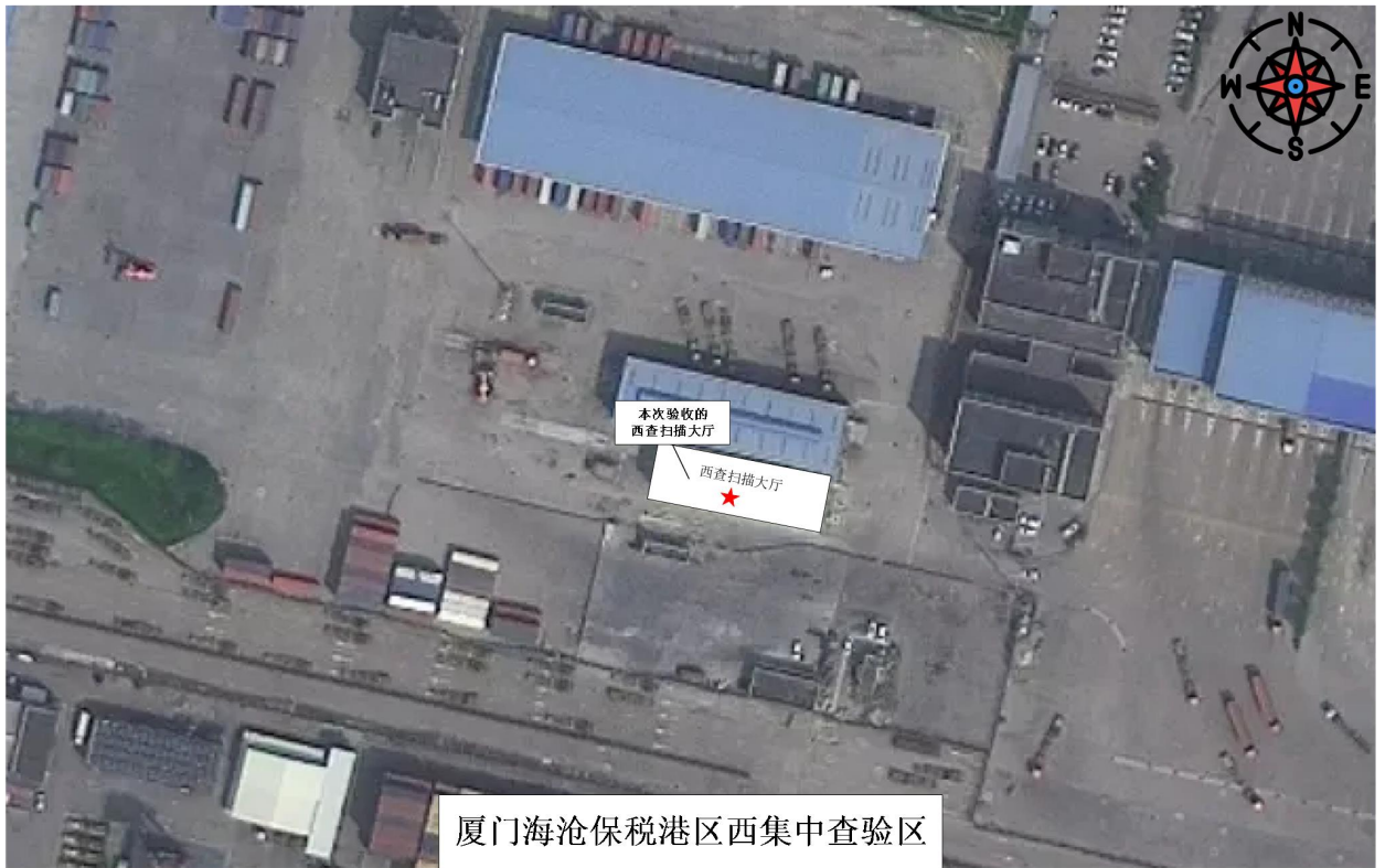
图2-4 厦门海沧保税港区西集中查验区扫描大厅
